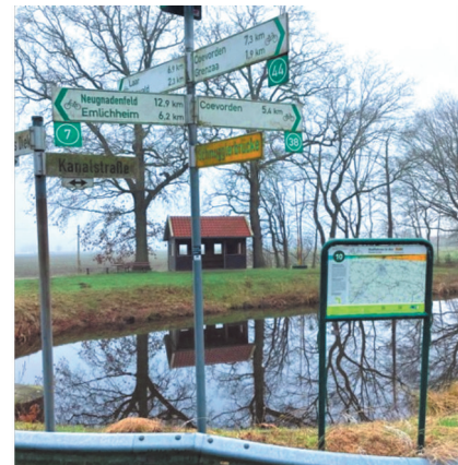
Knotenpunkt mit Orientierungstafel und Begleitinfrastruktur
